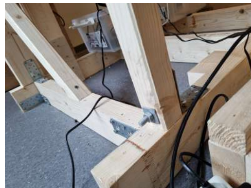
Figur 20: Bein festest/løsnes med bolter og muttere øverst og nederst.
