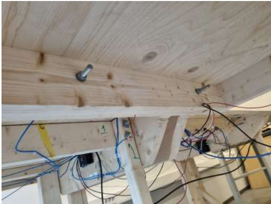
Figur 19: Gjengestaver og muttere holder modulene sammen.
