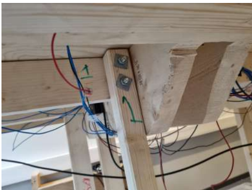
Figur 20: Bein festest/løsnes med bolter og muttere øverst og nederst.
